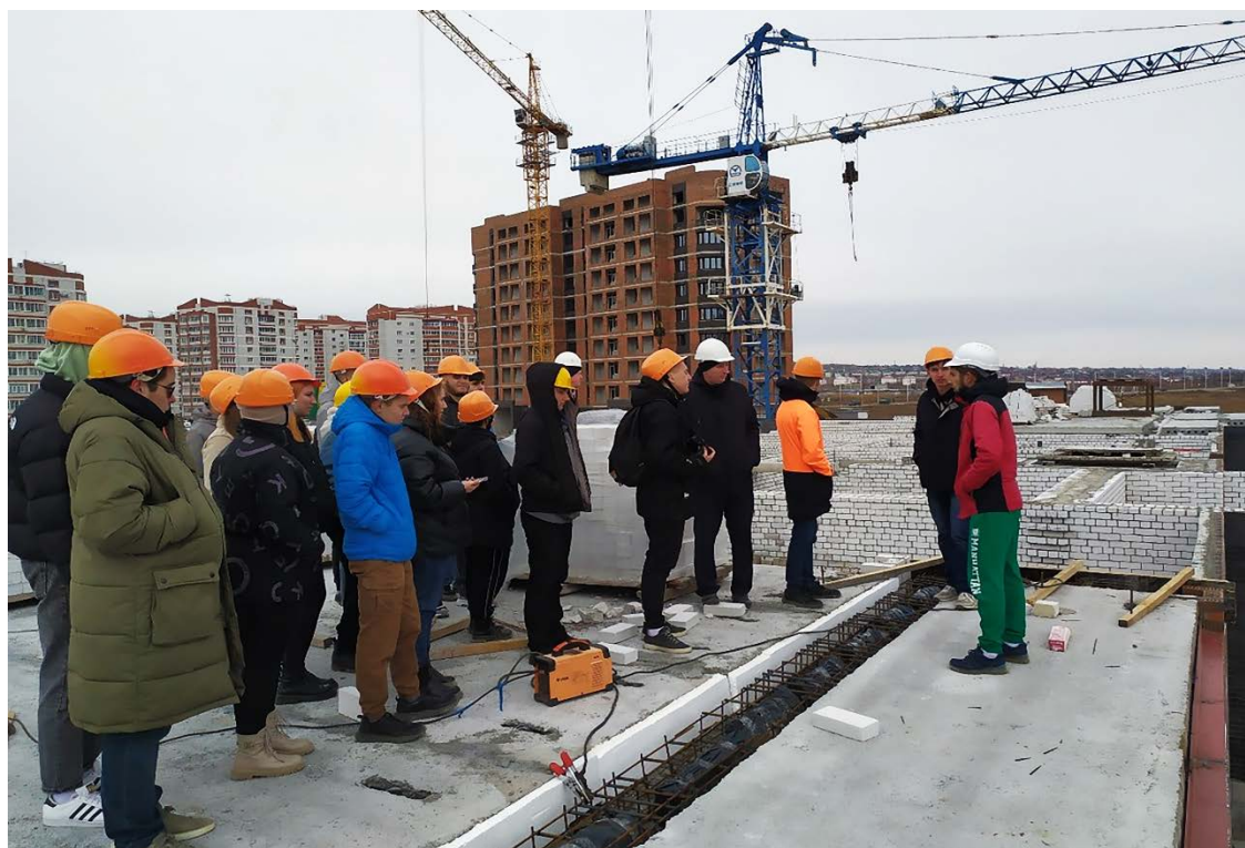
Рисунок 1 – Выездное практическое занятие на строящийся объект в 406 квартале г. Благовещенска (жилищный комплекс «Современник»)
