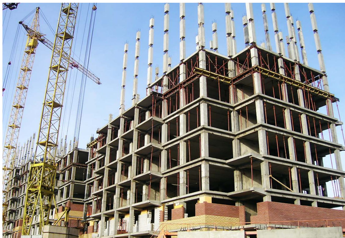
Рисунок 1 – Сборно-монолитное каркасное домостроение
